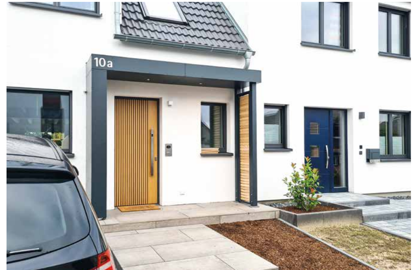
↑ Eingangüberdachung S.1 mit zwei Stützen Fassadenplatten in anthrazit mit Sichtschutzelement in blickhemmender, unbehandelter Holzlattung und Einbaustrahlern
