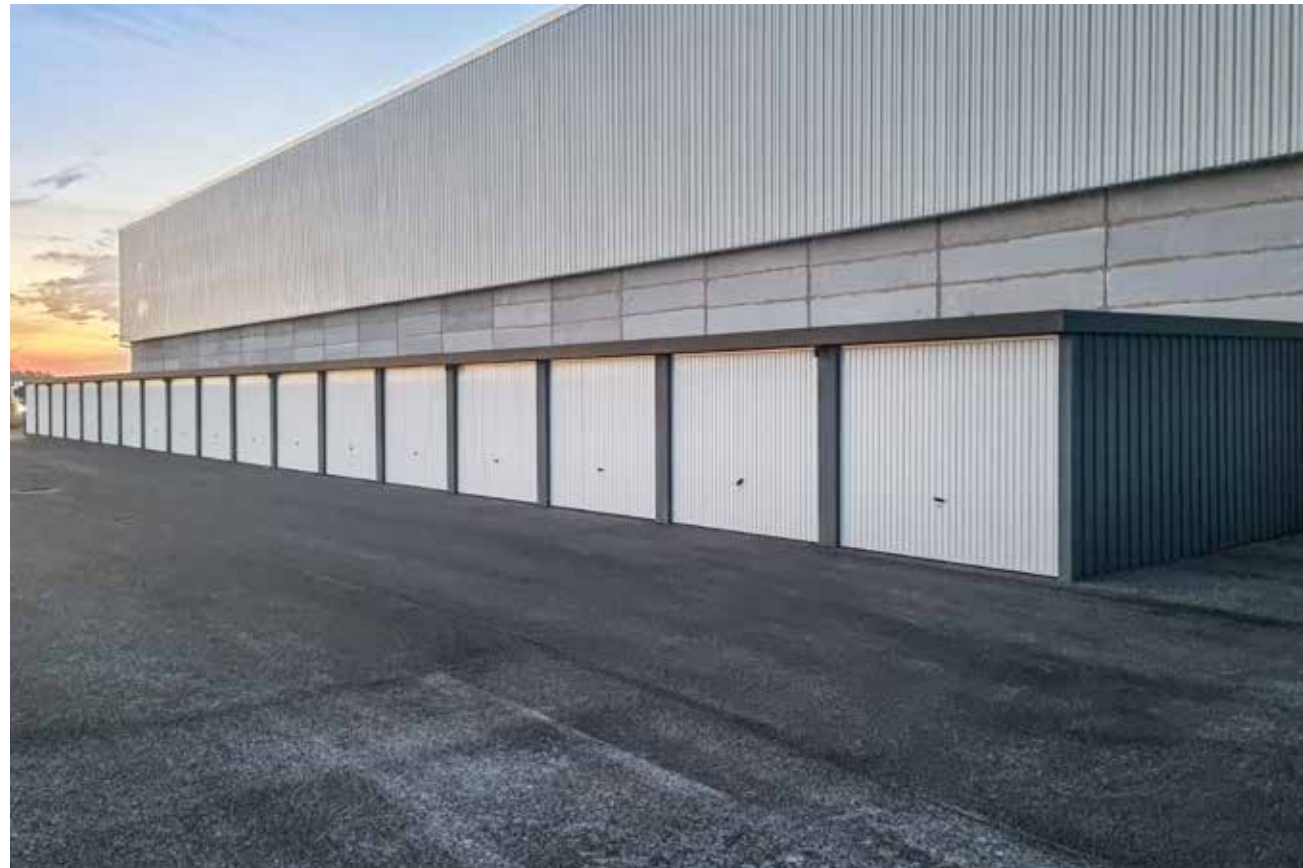
↑ Strukturwand-Reihenanlage Garagenanlage als Vermietungsobjekt. Dekorputz in anthrazit. Ausstattung mit Schwingtoren
