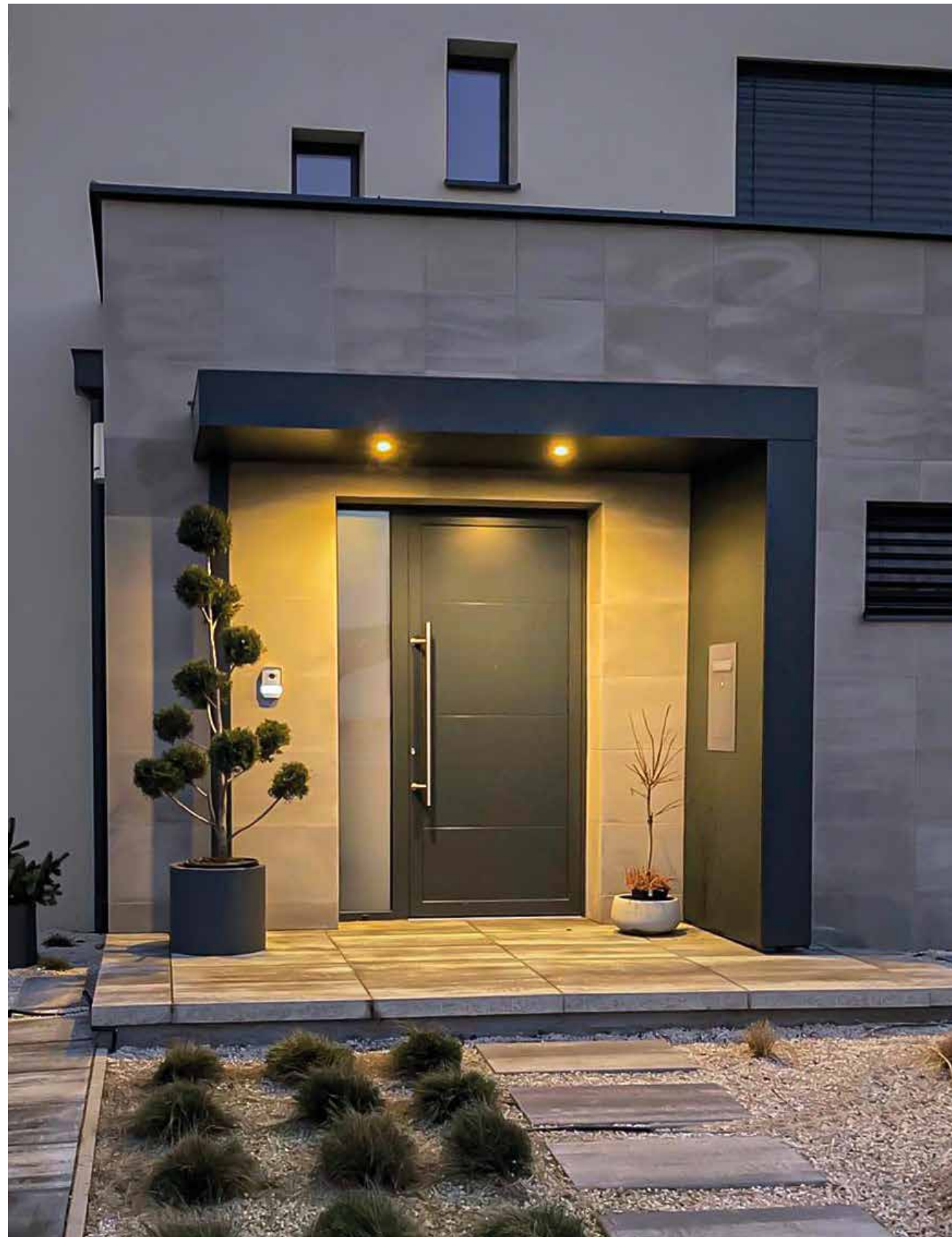
↑ Eingangüberdachung S.1 mit Stütze Eingangüberdachung mit Briefkasten und Einbauleuchten. Stütze an der offenen Seite - somit keine Verankerung in der Hauswand
